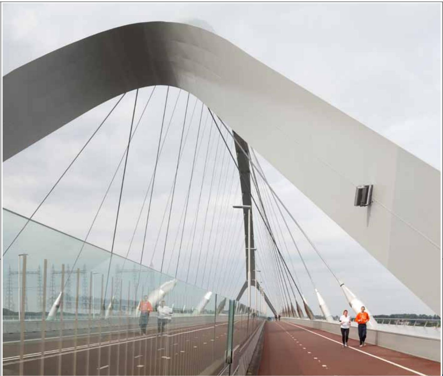
Door gebruik te maken van de krachtswerking van de boog is de brug met een minimum aan staal uitgevoerd. Vanwege deze slankheid van de brug, de beeldkwaliteit en de eisen voor de brandveiligheid is geopteerd voor hoogwaardig staal.
